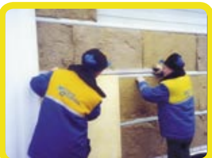
Монтаж ограждающих конструкций
