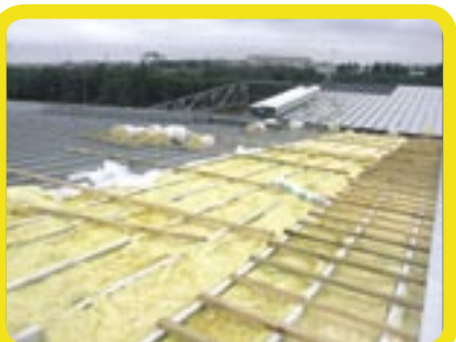
Монтаж кровельных сэндвич-панелей.
