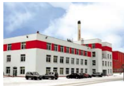
г. Выборг, Ленинградская обл.
