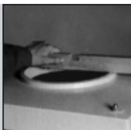
**42.** Положение покрывной плиты проверьте уровнем.
