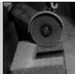
**20.** Угловой шлифовальной машиной вырежьте отверстие.
