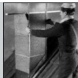
**36.** Наложите рейки толщиной около 3 см на верхнюю часть готовой каменной оболочки дымовой трубы и снимите требуемые размеры до выполненной конструкции крыши.
