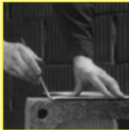
2. Отметьте величину отверстия для нижней заглушки. Нижняя заглушка входит в состав основного комплекта. Размеры отверстия выполните в соответствии с расстоянием между креплениями на тыльной стороне нижней заглушки.
