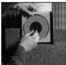
**21.** Установите керамическую трубу внутрь каменной оболочки и обозначьте на сухой поверхности трубы место подключения потребителя. Керамическую трубу с меткой выньте для дальнейшей обработки.
