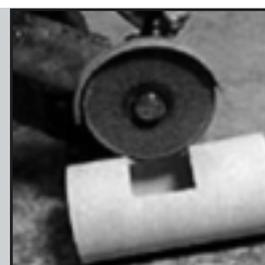
**24.** Угловой шлифовальной машиной выполните надрезы на поверхности трубы. Не рубить и не сверлить ударной дрелью!!!
