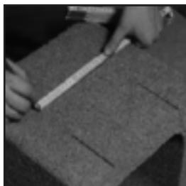
**19.** Отметьте на каменной оболочке отверстие размером 20 x 20 см для подключения потребителя. Положение и ориентация отверстия должны соответствовать проекту.
