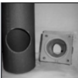
**22.** Выполните в керамической трубе отверстие  $\varnothing$  112 мм при помощи буровой коронки. Допускается выполнять отверстие в трубе не только круглой, но и квадратной формы (рис. 23).
