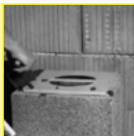
**15.** Используя монтажный шаблон, нанесите раствор на поверхность каменной оболочки для установки следующего элемента.
