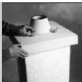
**46.** Закрепите покрывную плиту при помощи винтов.
