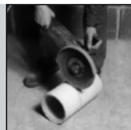
**44.** Обрежьте керамическую трубу угловой шлифовальной машиной, после чего очистите оба конца трубы от пыли. Обильно нанесите на трубу герметик Rotemp и установите её на место.
